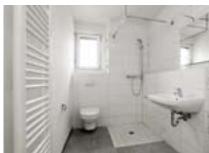
Das fertige Bad
