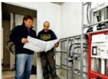
Einweisung auf der Baustelle
