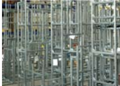
Vorfertigung im TECE-Werk
